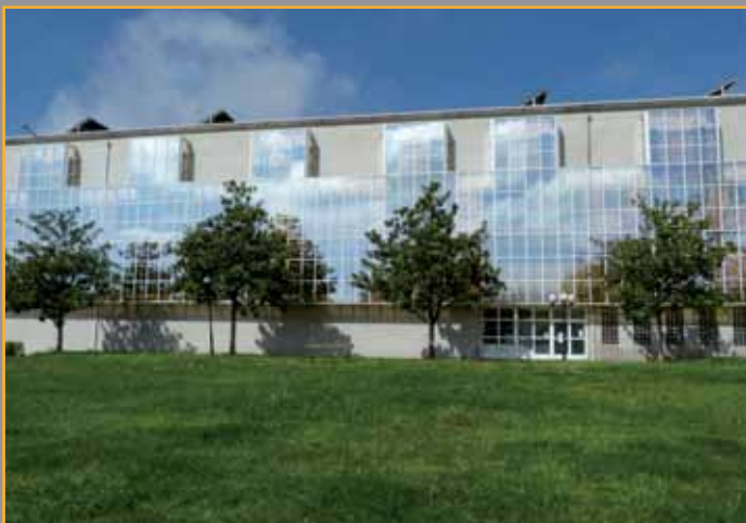
Edificio del pabellón deportivo.
